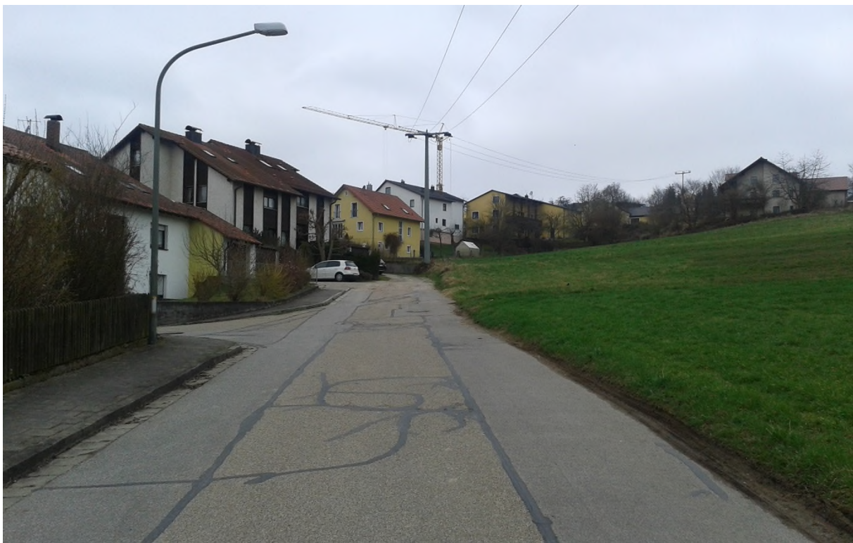
Blick auf den (offenen) Gebrachinger Weg Richtung Westen mit Stromfreileitung, rechts: geneigte Änderungsflächen
